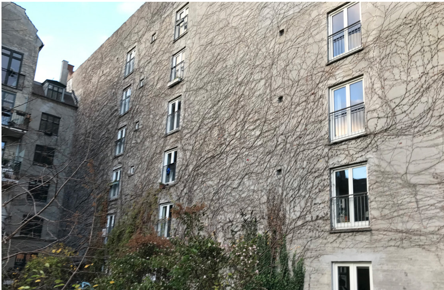
Case #1: Ejendom på Blågårdsgade, som skal efterisoleres (side 12)
