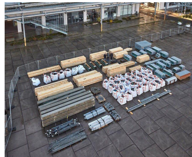
Konstruktion – Design for adskillelse: Med lånte basale (nye) materialer, og brugte materialer fra andre byggerier
